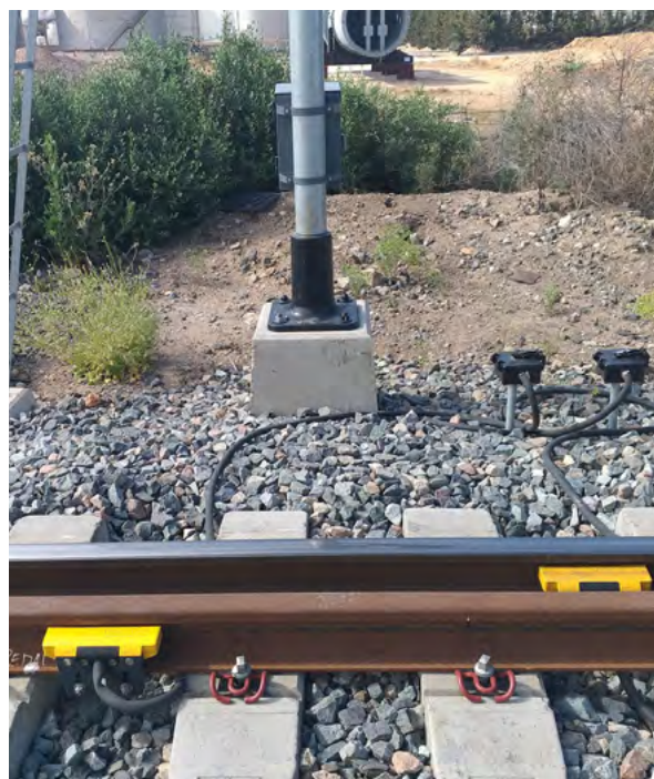
Датчик колес Frauscher RSR123
